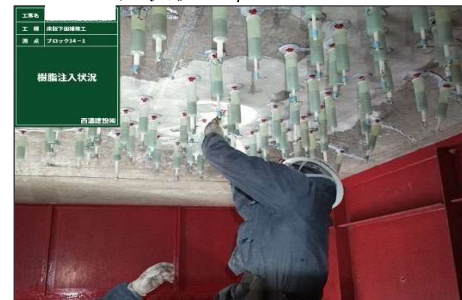
⑤注入状況
