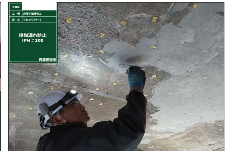
③樹脂漏れ防止状況
