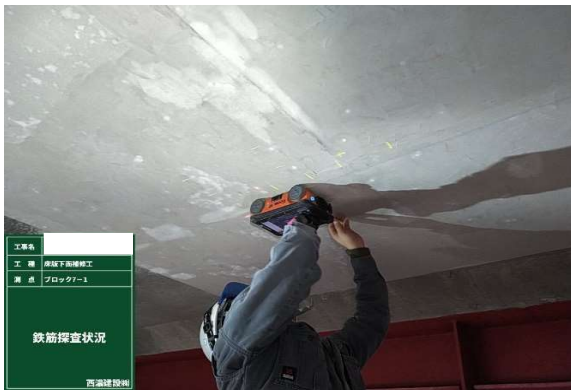
探査状況 ブロック7-1
