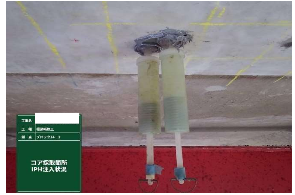
コア補修後注入
