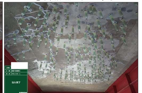
⑥注入完了 加圧養生
