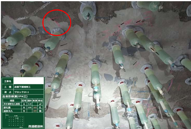
追加注入状況 正の字マーキング
