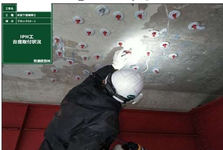
④台座取付状況
