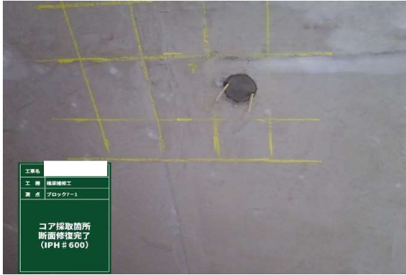
注入孔を確保して断面修復
